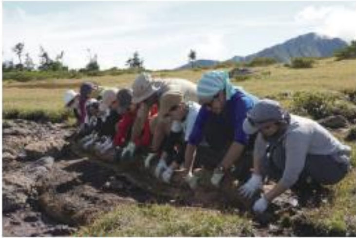
土壌流出防止の土留めロールを設置
