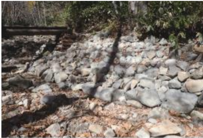
沢の護岸のため石積みを施工
