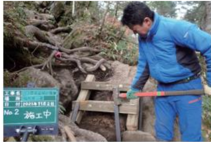
ステップ設置。階段工事は歩きやすさを考え勾配を変えて準備
