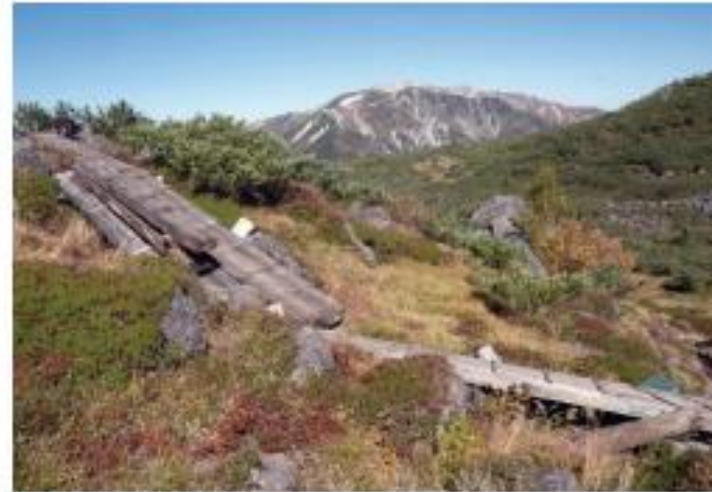
作業前の状況
