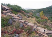
作業後の様子
