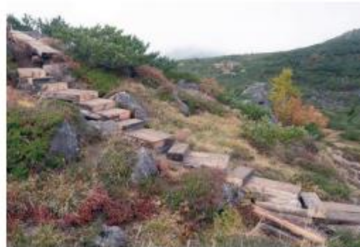
作業後の様子
